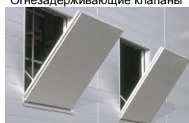
Клапаны дымоудаления и подачи воздуха
