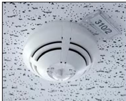
Рисунок 40 – Маркировка адресов на извещателях серии IQ8Quad
