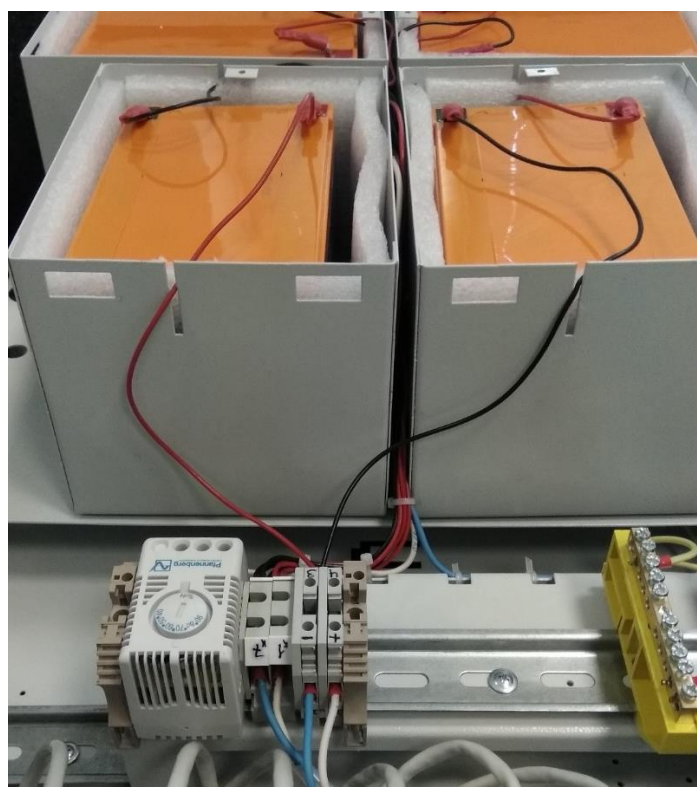
Рисунок 9.5 – подключение сборки АКБ к клеммам на DIN-Рейке
