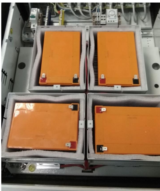
Рисунок 9.3 – АКБ, установленные в термостаты
