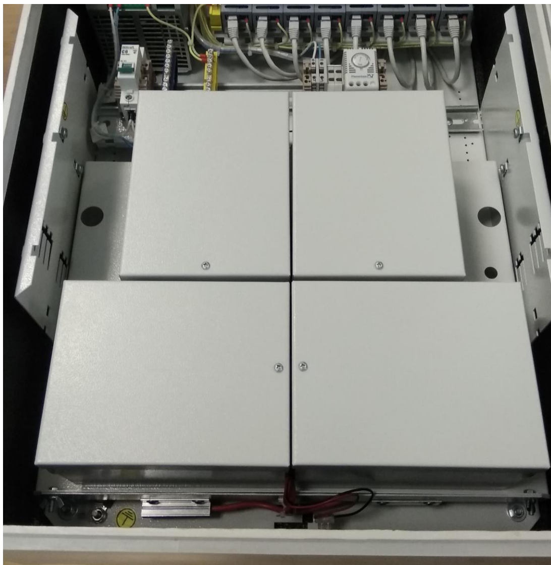
Рисунок 9.8 – Закрывать термостаты АКБ
