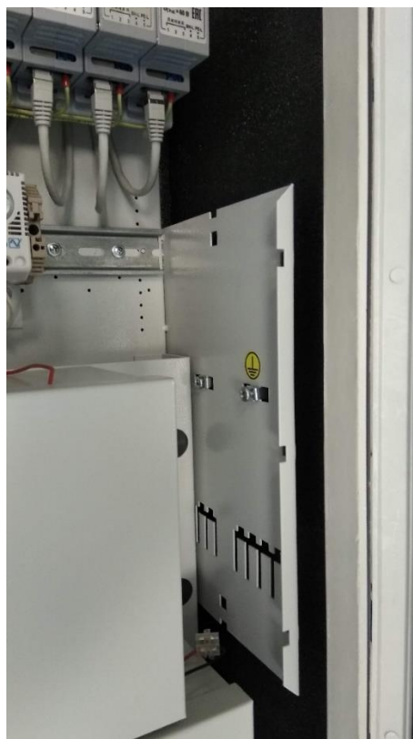
Рисунок 8.4 – Правая боковая панель для укладки кабеля
