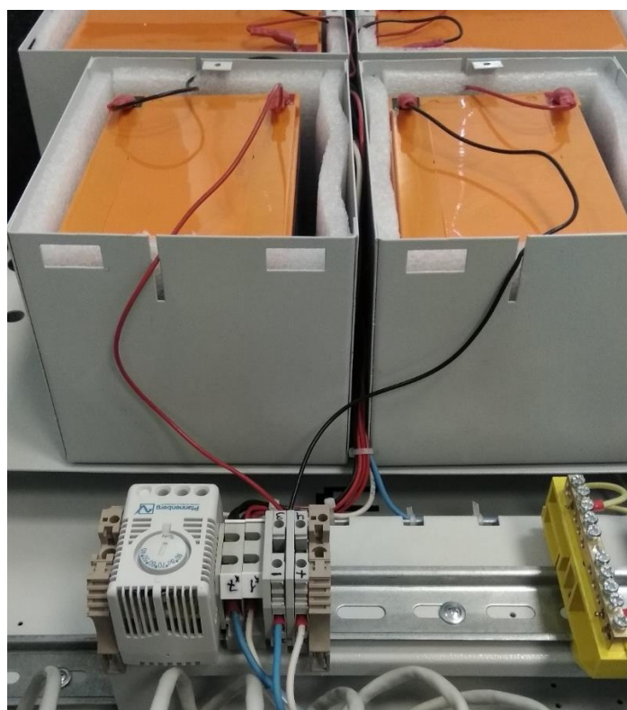
Рисунок 9.5 – подключение сборки АКБ к клеммам на DIN-Рейке
