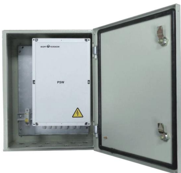
Рисунок 7.3 - Монтаж коммутатора в уличном шкафу.
